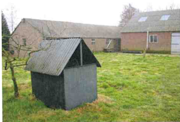
Fotonummer: 11 Omschrijving: Bovengrondse dieseltank
