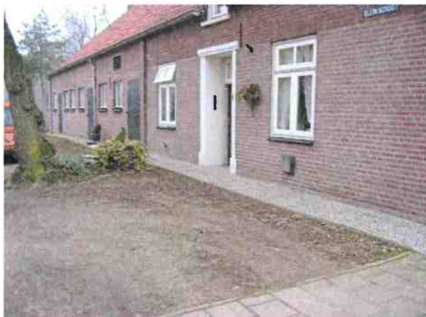
Fotonummer: 1 Omschrijving: Puinverharding voor huis en langs Klein-Schoot
