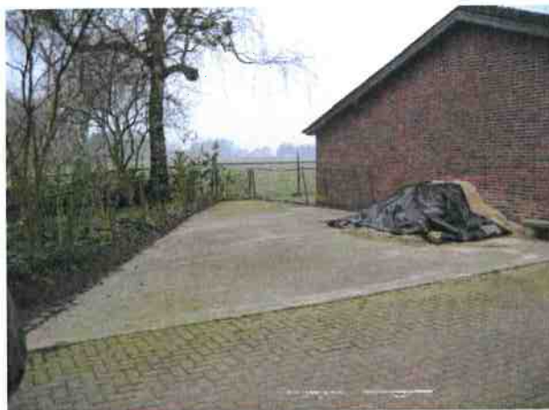
Fotonummer: 8 Omschrijving: Beton voor schuur naast oprit
