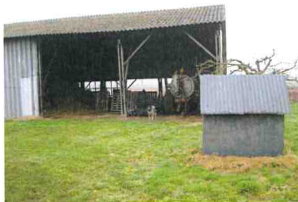
Fotonummer: 12 Omschrijving: Bovengrondse dieseltank
