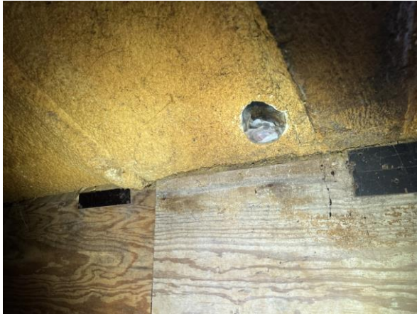
PUR isolatie plafond stal 4
