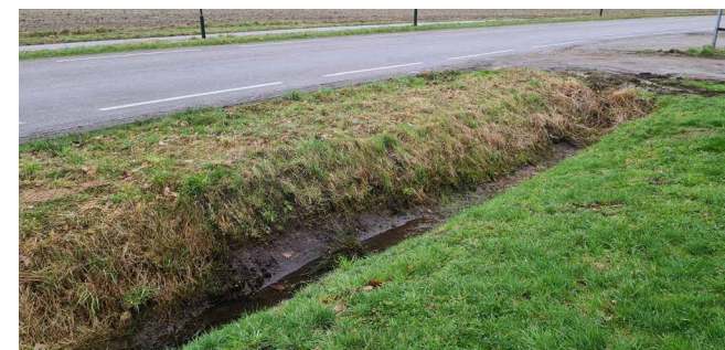
Figuur 14: Aanwezige greppels aan de straatzijde
