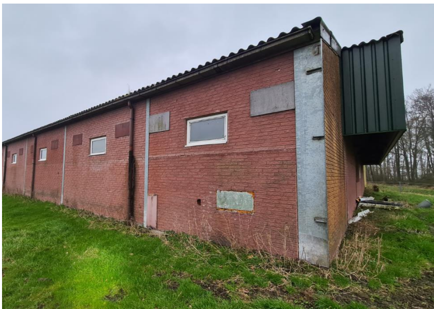
Figuur 6: Nog in gebruik zijnde bedrijfshal in het noordwesten van het plangebied
