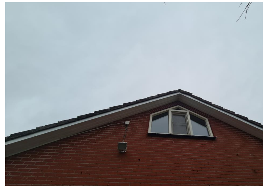
Figuur 5: Detailopname dakrand
