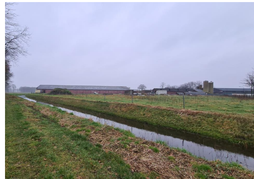
Figuur 8: Plangebied gezien vanuit het zuiden
