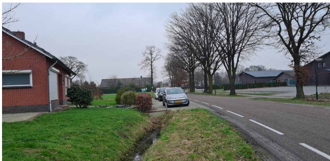
Figuur 9: De aanwezige bedrijfswoning georiënteerd op Het Laar
