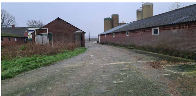
Figuur 11: De aanwezige opstallen op het terrein met aanwezige silo's op de achtergrond
