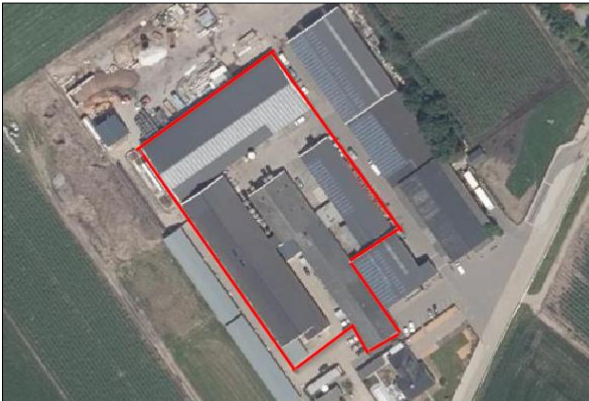
Rood omkaderd te slopen gebouwen
