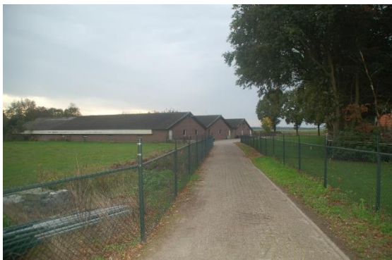
Afbeelding 26: stallen gezien vanaf centraal
