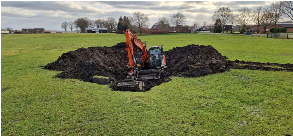
Figuur 8: De vastgereden graafmachine die tevergeefs tracht zich te bevrijden. Hierdoor en door het uiteindelijk met een tweede graafmachine lostrekken van de vastgereden graafmachine, ontstaat de op de onderstaande foto vanuit de lucht gefotografeerde ravage.
