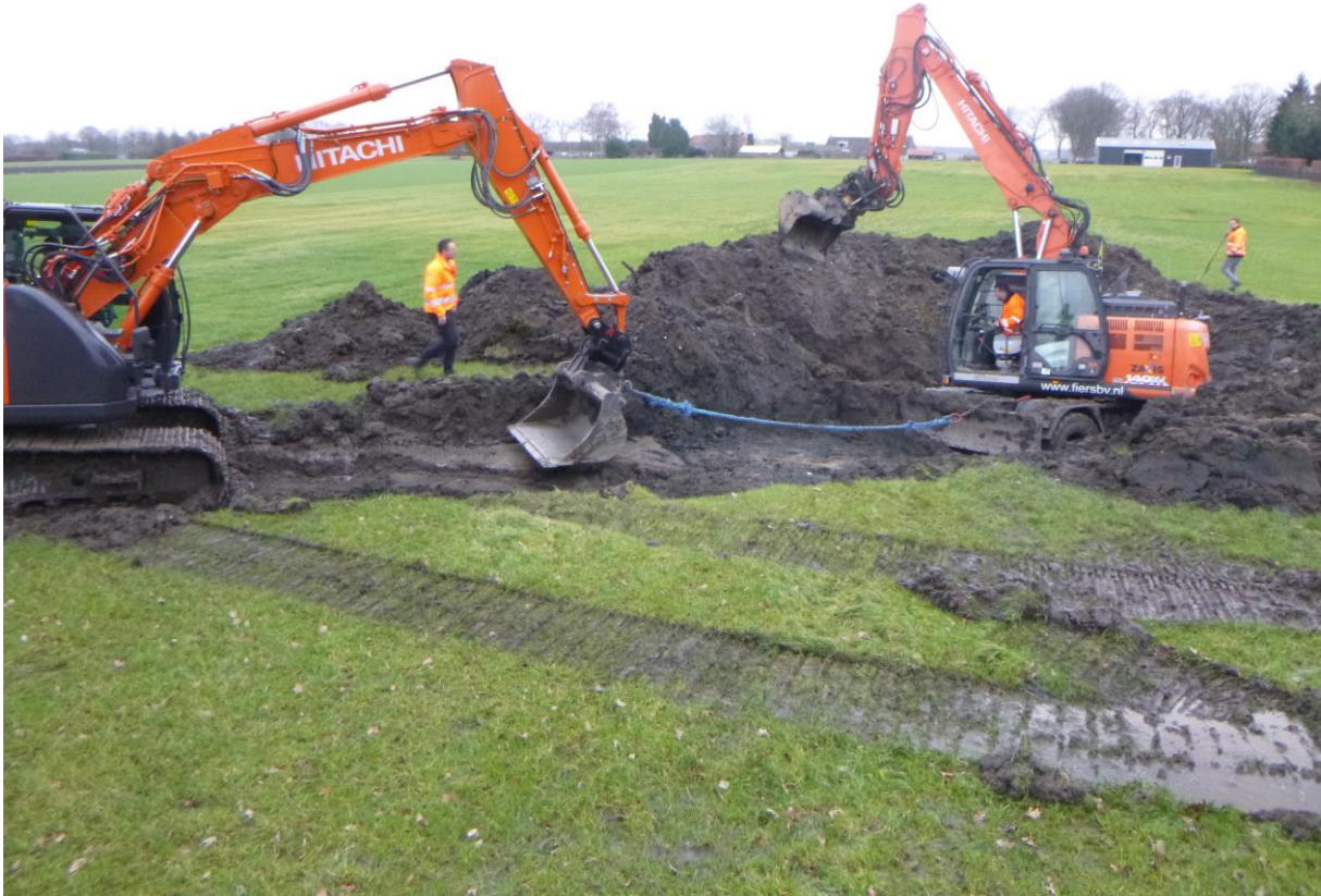
Figuur 22: Het lostrekken van de graafmachine die zich onderweg naar proefsleuf 3 had vastgereden.
