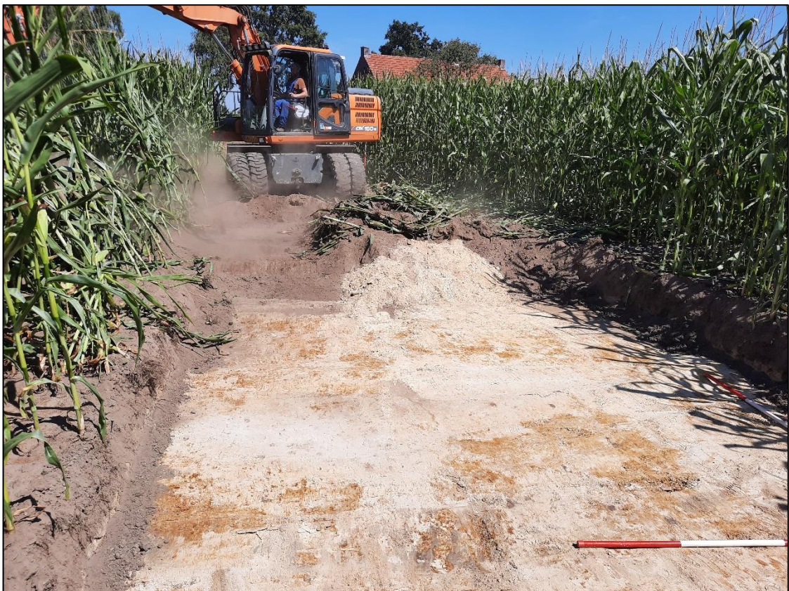
Figuur 4. Sfeerfoto van de aanleg van werkput 4.
