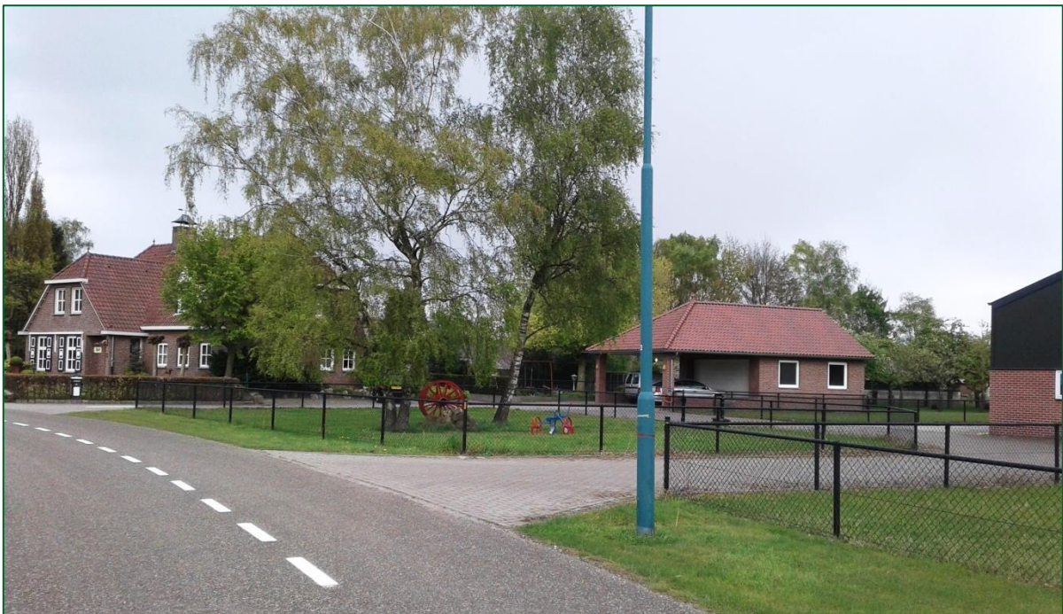
Afbeelding 20. Kwaliteitsverbetering, bestaand straataanzicht in noordoostelijke richting met garage/carport en klein deel te slopen loods
