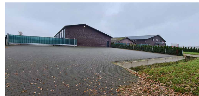
Figuur 13: Zicht op het bedrijfsp perceel vanaf de inrit
