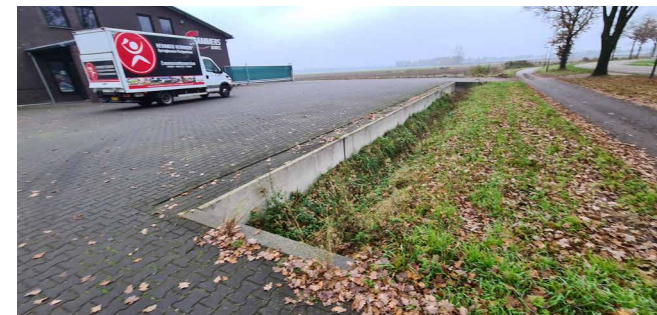
Figuur 12: De ingedamde sloten aan de westzijde van het bedrijfsp perceel
