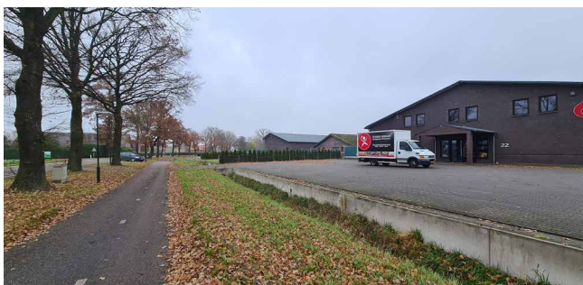
Figuur 10: Zicht vanuit het zuiden met het aanwezige fietspad
