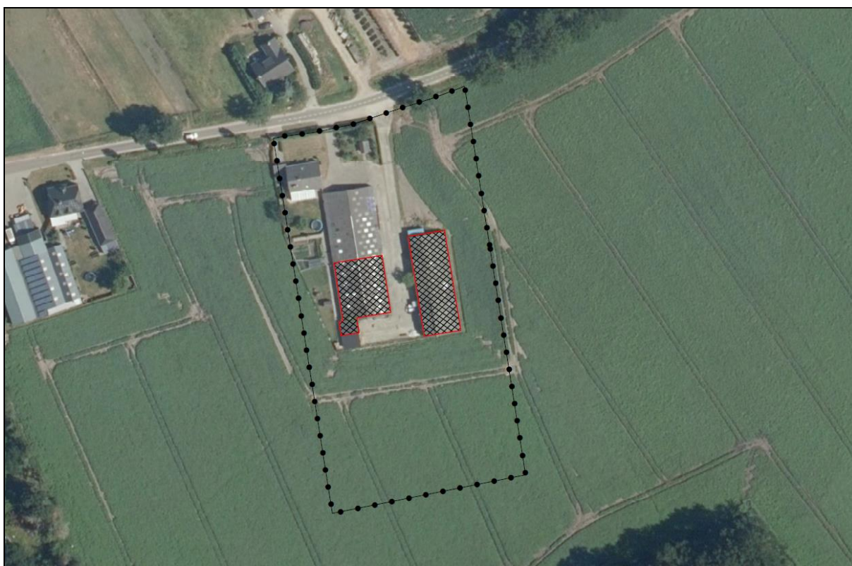
Figuur 6: Te saneren bebouwing
