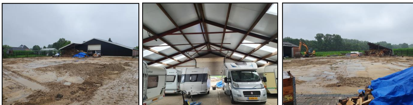
Zicht vanuit zuidelijke richting op het te behouden staldeel, de binnenzijde van de stal en zicht op het reeds gesloopte deel van de stal in zuidelijke richting.
