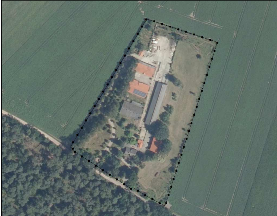
Figuur 5: Luchtfoto van de huidige situatie binnen het plangebied
