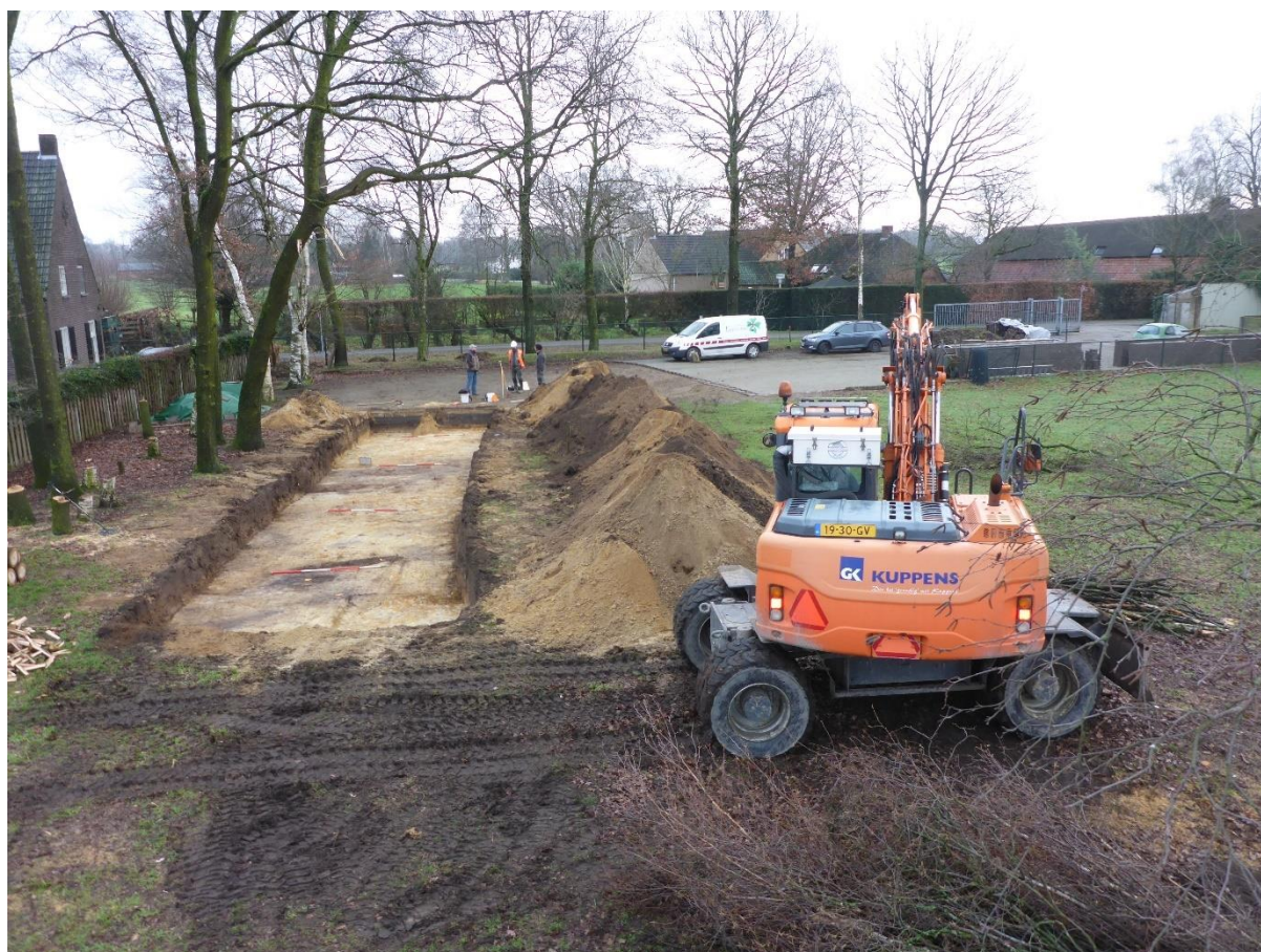
Figuur 6 Overzicht van het plangebied vanuit het westen gezien. Aangelegde proefsleuf nabij erf en oude doorgaande weg van/naar het gehucht Keunenhoek (rechts).
