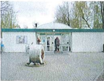
Bestaande sanitaire unit
