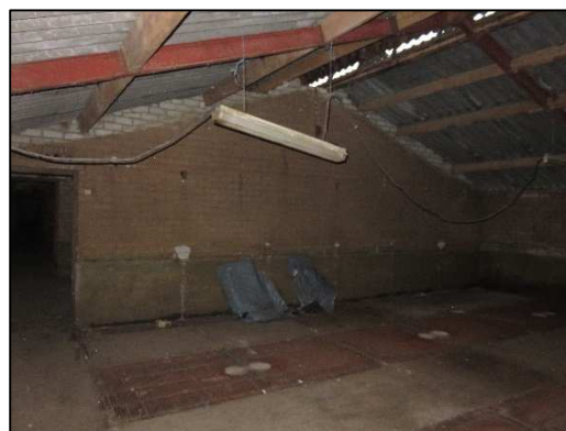
Foto 6. Plangebied 1, binnenzijde stal
