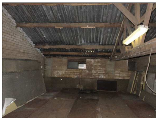
Foto 5. Plangebied 1, binnenzijde stal
