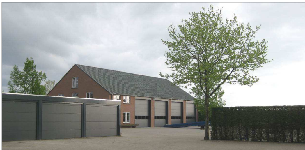
Figuur 6: Beeld van het bedrijfsgebouw op het perceel, opgericht in 2011 met op de voorgrond de carport/opslag
