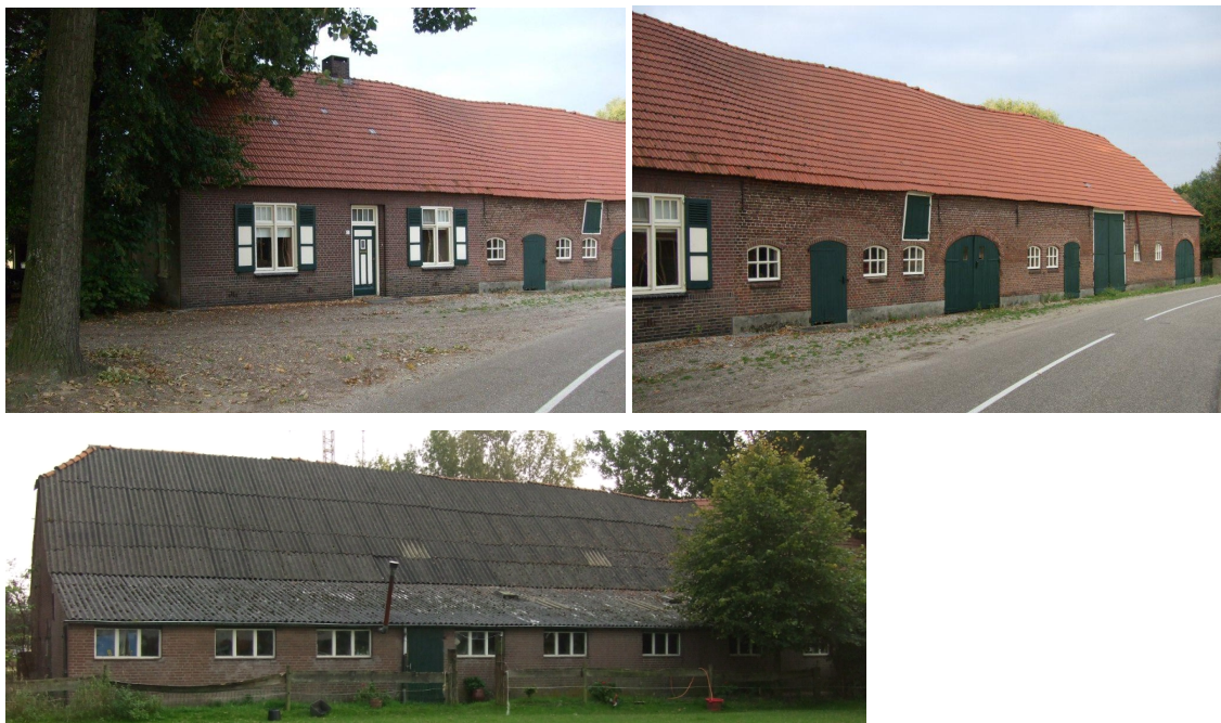
Foto's bestaande situatie
