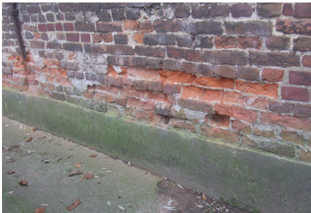
Afschilfering metselwerk
