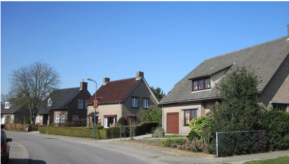
B11. Deze rij vrijstaande suburbane woningen volgen de bocht van de weg. Kenmerkend is de toepassing van zadeldaken, eventueel met een doorgeschoten dakvlak boven een uitbouw aan de voorzijde of achterzijde. Alle gebouwen hebben minstens één schoorsteen, meestal op de geveltop. Ook hier zijn de dakkapellen voornamelijk onder een vlijkap gebracht; in een enkel geval is een steekkap toegepast. De gevelkleur is opvallend licht.
