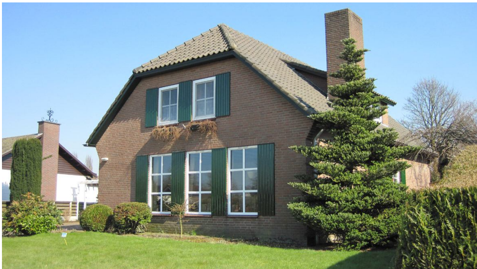
B15. Nogmaals een haaks op de weg gesitueerde woning van een landelijk type met afgewolfde dakeinden en rustieke details zoals de vlakke luiken en de grote schoorsteen. Ook hier weer een dakkapel onder een vlijkap en een overstek van de dakrand.
