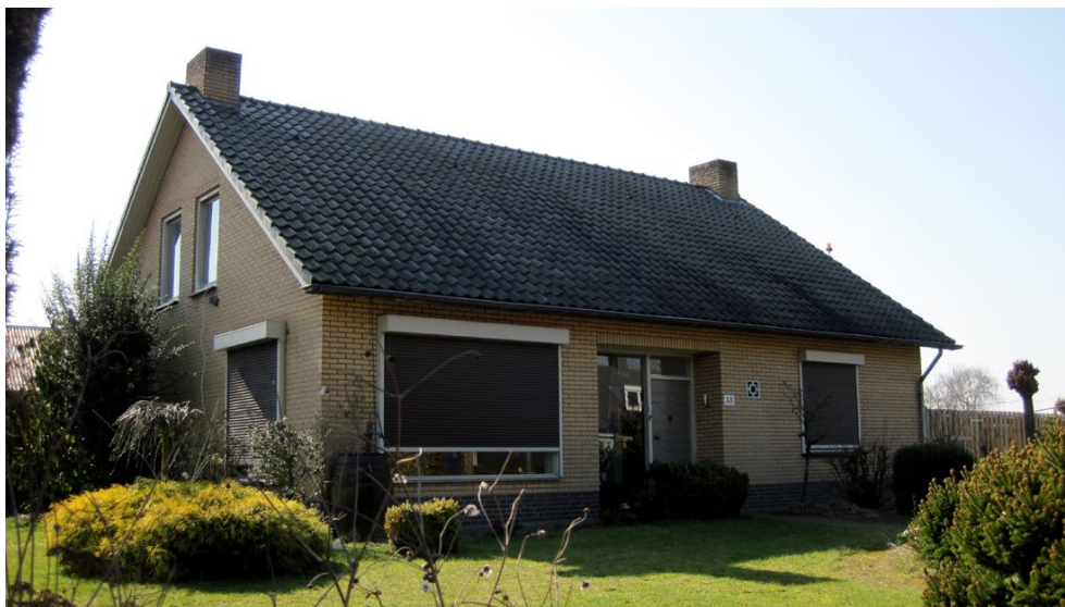
B12. Nogmaals een woning met een lichte gevel, deze keer in gele baksteen. Het betreft een eenvoudig volume onder een zadeldak van een suburbaan type met korte schoorstenen op iedere geveltop. De entree is in een gevelnis gelegen.
