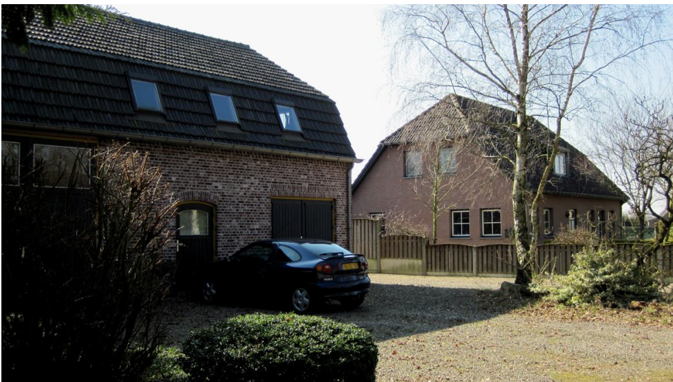
B7. Naast deze tot woning verbouwde voormalige boerderij (links) staat een boerderij-achtig woonhuis met wederom afgewolfde dakeinden. Opvallend aan de oude boerderij is het mansardedak dat leefbaar is gemaakt middels dakramen. Daarmee wordt het onderscheid met de naastgelegen woning benadrukt, deze heeft immers dakkapellen onder een vlijkap.
