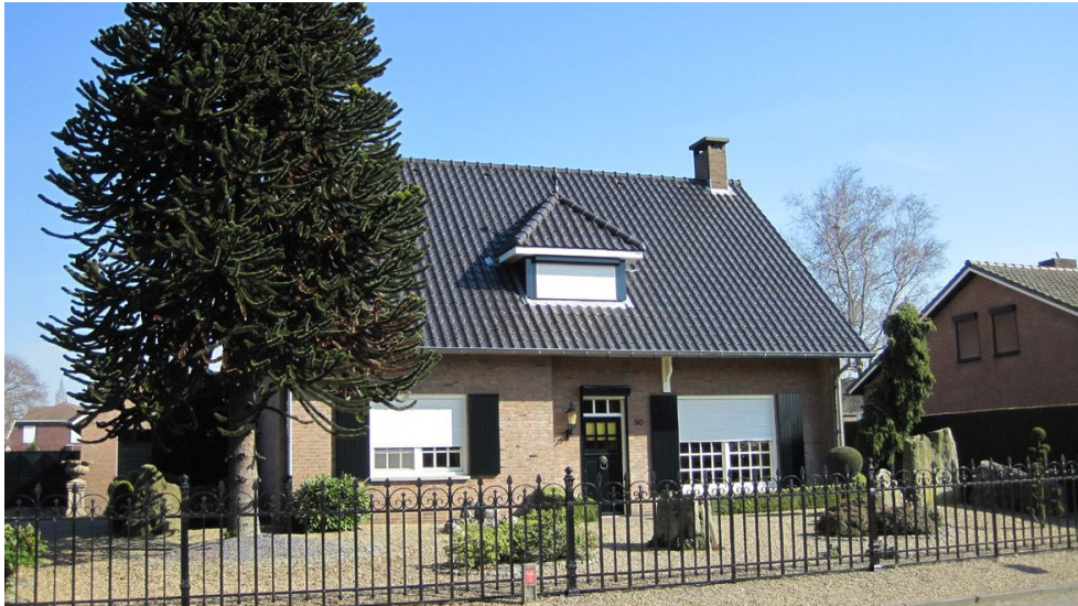
B21. Nogmaals een subuurbaan type woning, maar nu met landelijke details waaronder de platte luiken, de roedeverdeling in de ramen en het bovenlicht boven de voordeur. Boven de voordeur een kleine dakkapel met een gestoken schilddak. Ook hier is een deel van de voorgevel teruggelegd waarbij de dakoverstek wordt ondersteund door versierende houten schragen.
