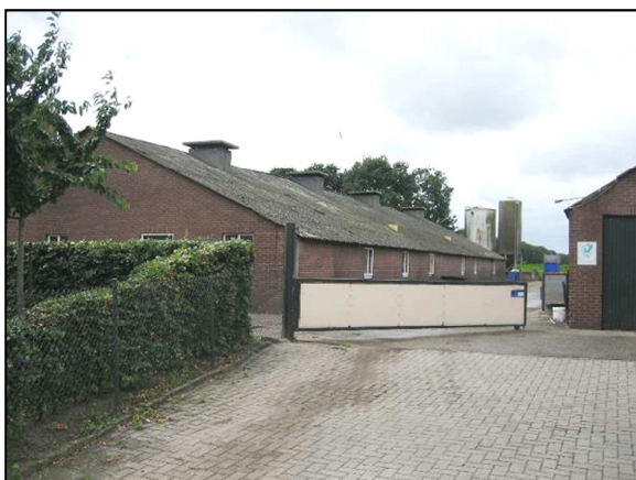
Figuur 34. Foto van de bedrijfsopstand op de planlocatie aan de Zitterd 61 te Soerendonk die gesloopt gaat worden.
