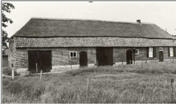
Figuur 37. Foto van de woning gelegen aan de Heistraat 13 te Gastel.
