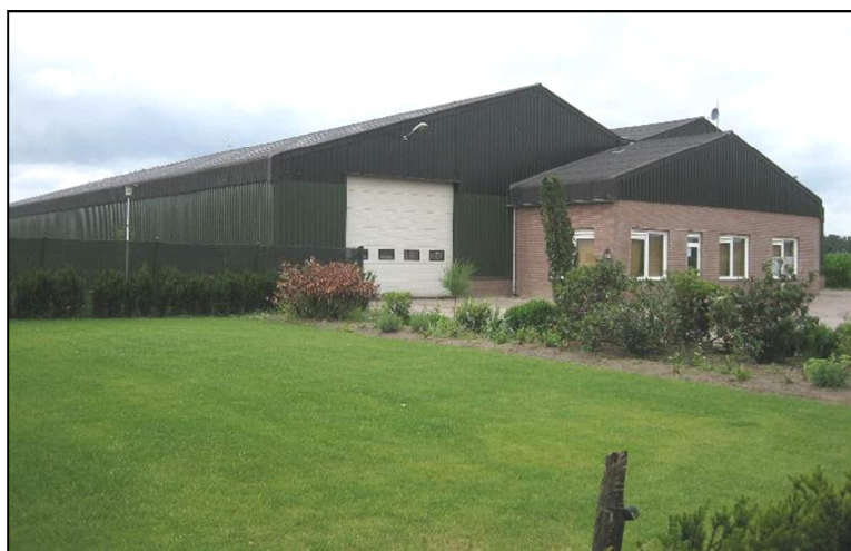
Figuur 19. Foto van de loods die thans aanwezig en in gebruik is aan de Zitterd 61 te Soerendonk ten behoeve van de verwerking van restproducten uit de levensmiddelenindustrie.
