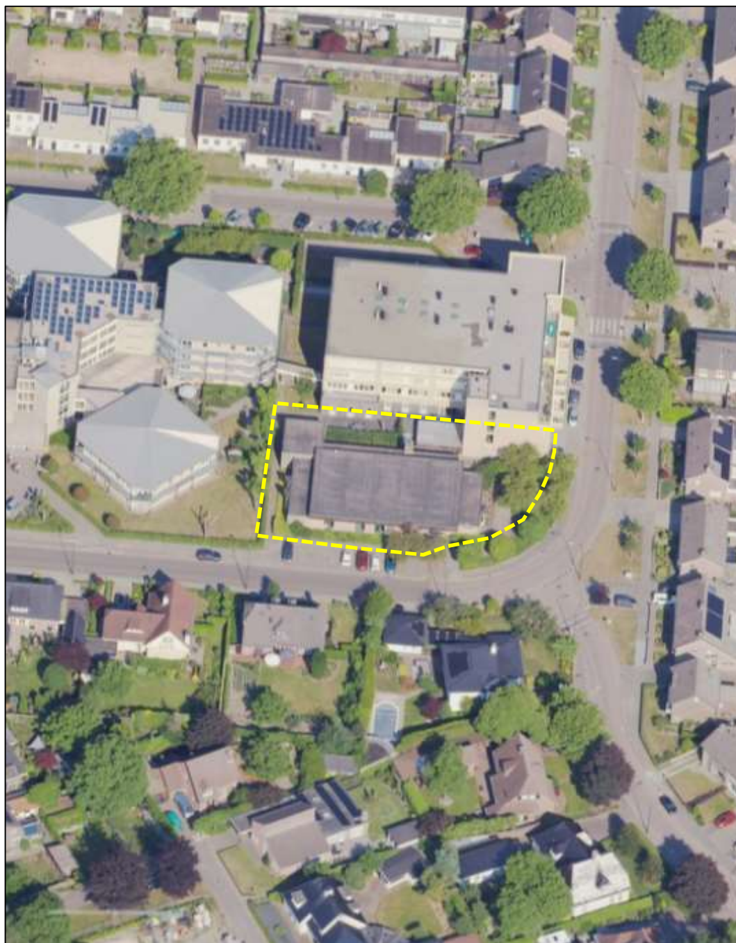
Figuur 2.3 Luchtfoto huidige situatie
