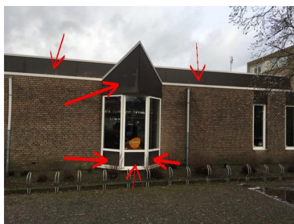
Beplating zijgevel rechts van de ingang
