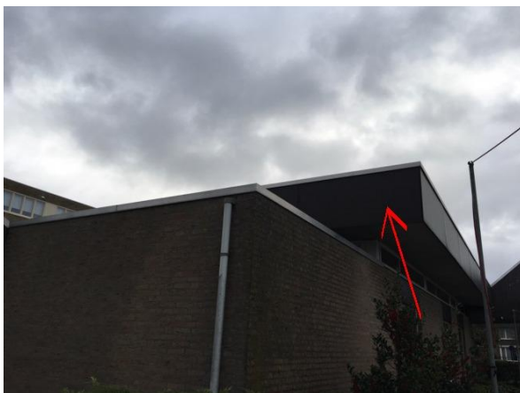
Beplating zijgevel links
