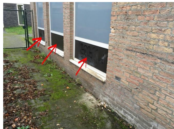
Beplating zijgevel links
