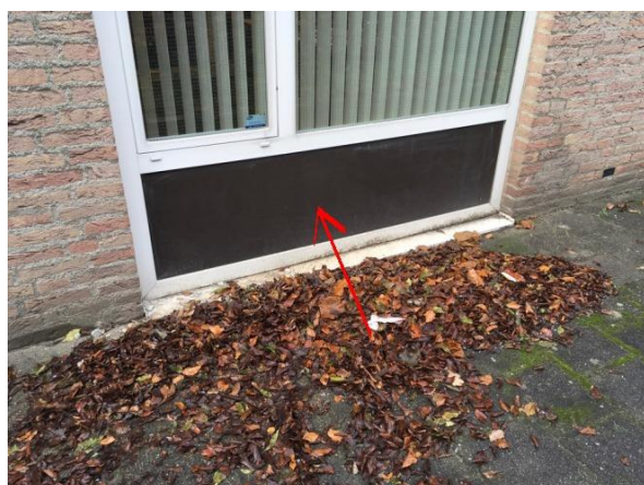
Beplating in kozijnen
