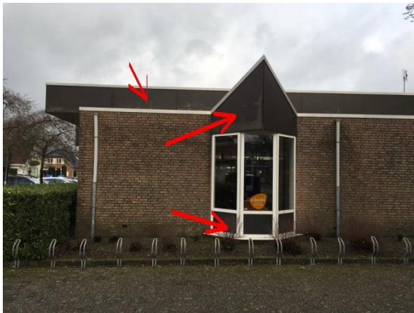
Beplating zijgevel rechts van de ingang
