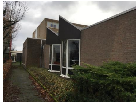
Beplating zijgevel links
