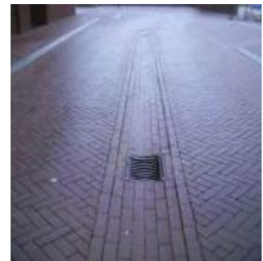
Referentiebeelden van een lage, overrijdbare betonband (links), de zelfde betonklinkers als in de omliggende omgeving (midden) en een molgoot van het standaard verhardingsmateriaal als scheiding tussen de rijloper en de parkeervakken of middenin de rijloper (rechts).
