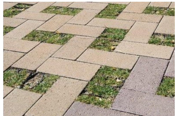
Referentiebeelden van de NCB grassteen van MBI in kleur antraciet (links) en hetzelfde materiaal als de rijloper in een “open” elleboogverband (rechts).
