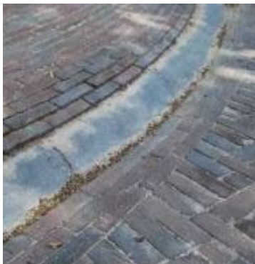
Referentiebeelden van een lage, overrijdbare betonband (links), de zelfde betonklinkers als in de omliggende omgeving (midden) en een molgoot van het standaard verhardingsmateriaal als scheiding tussen de rijloper en de parkeervakken of middenin de rijloper (rechts).
