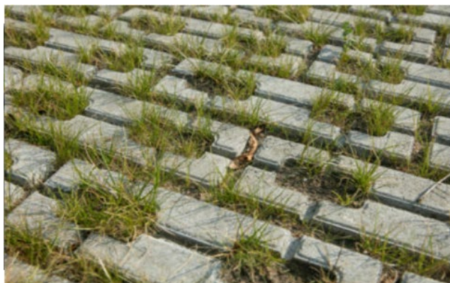
Referentiebeelden van de NCB grassteen van MBI in kleur antraciet (links) en hetzelfde materiaal als de rijloper in een “open” elleboogverband (rechts).
