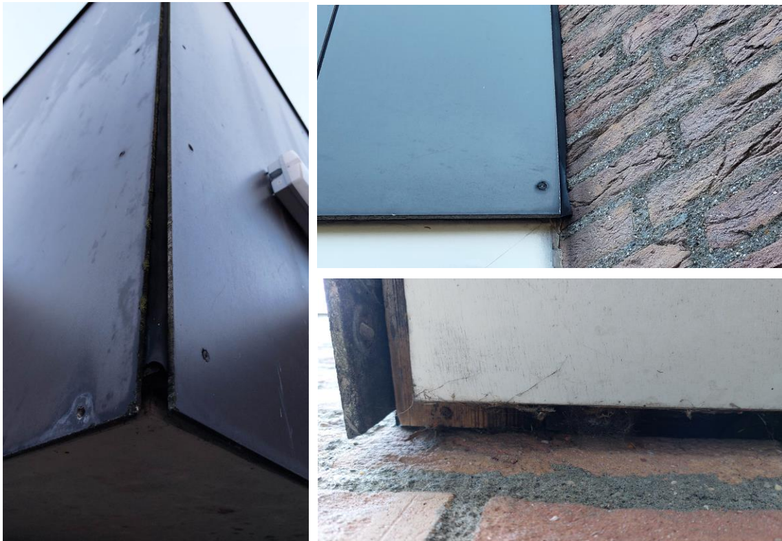
Figuur 4.4.1. Kieren en spleten zijn afgedicht met plastic, een houten lat of compriband.
