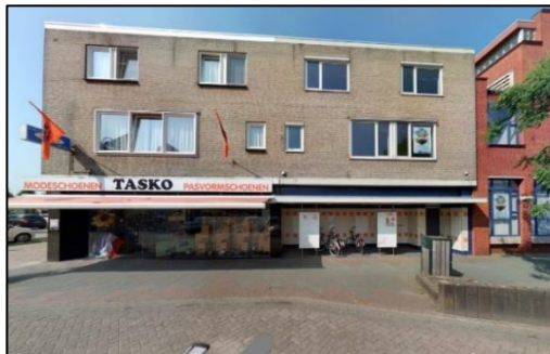
Zuidwestelijke gevel Capucijnerplein
