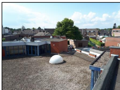
Figuur 7. Dak laagbouw
