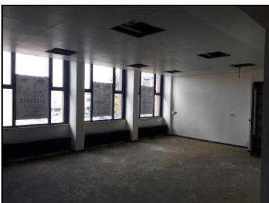
Figuur 6. Binnenzijde bovenverdieping
