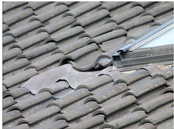
Figuur 12. Ruimte onder dakpannen bovenwoning.
