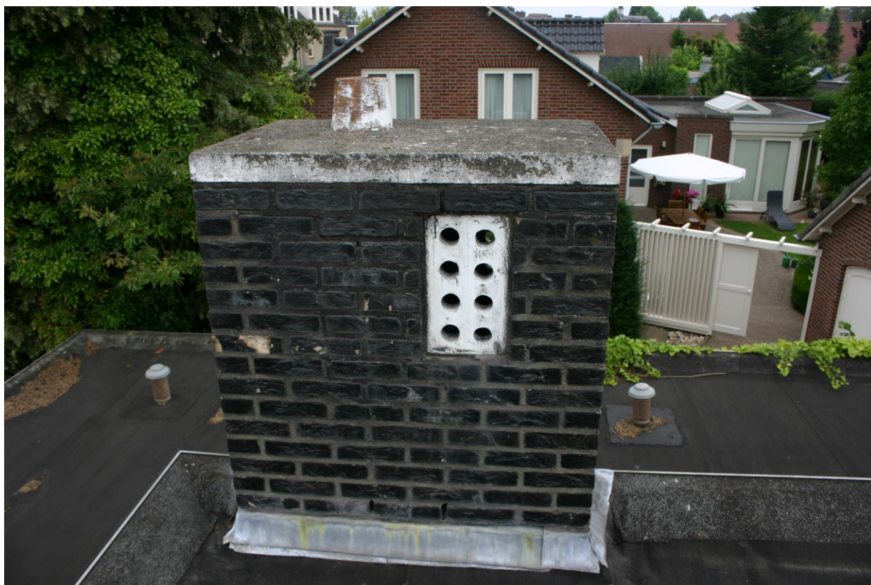
Figuur 4.5.1. De schoorsteen is geïnspecteerd; hierin bevinden zich geen vogelnesten.
