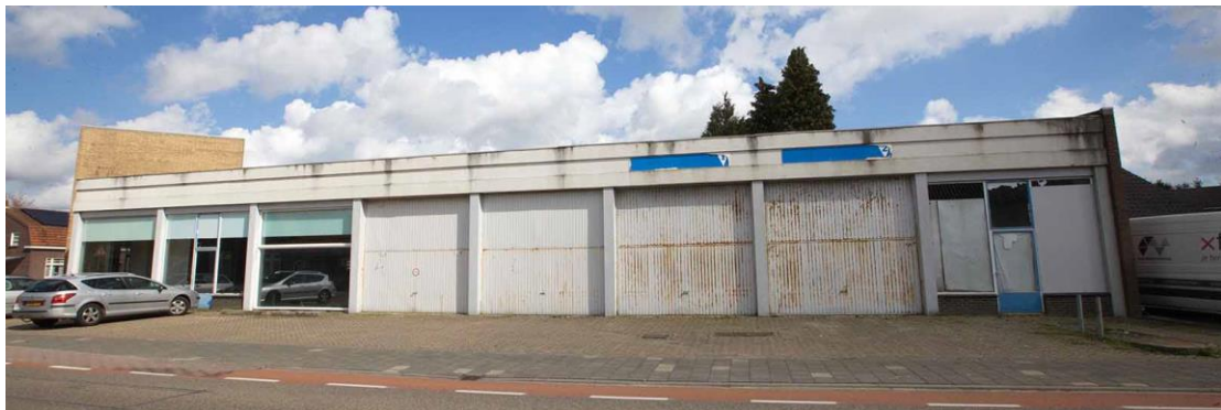
Figuur 10: Zicht op de zijgevel van de garage aan de Nieuwstraat.
