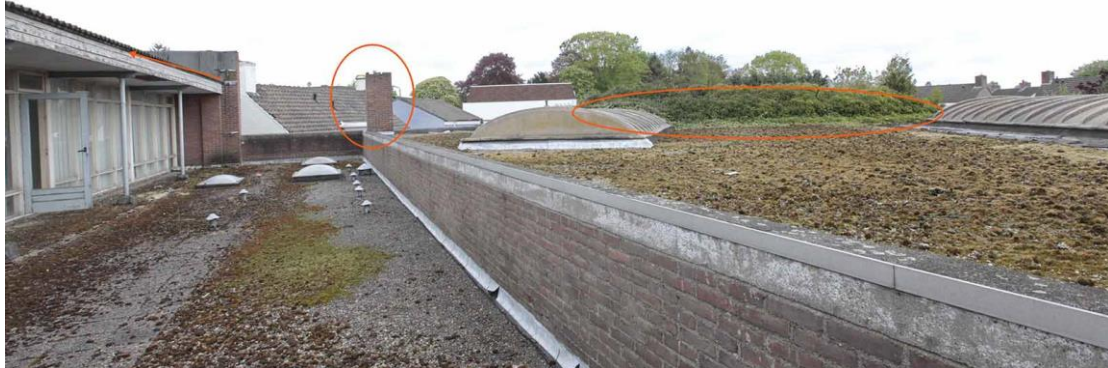
Figuur 7: Zicht op het dak en potentiële faunaverblijfplaatsen. Rode pijl: toegang onder golfplatendak; cirkel linkerzijde: schoorsteen met mogelijke toegang voor vleermuizen; rechter cirkel: hederavegetatie met mogelijkheden tot nestelen.
