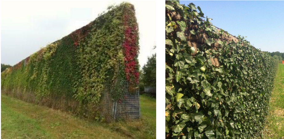
Figuur 2 Constructie bestaande uit een metalen raamwerk, ongevuld met een relatief licht materiaal (bijvoorbeeld kokos), begroeid met klimplanten
