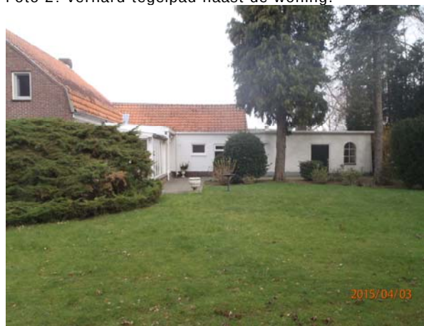
Foto 4: aanbouw woning achterzijde.
