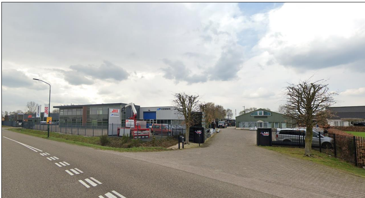
Figuur 5: Foto plangebied vanaf de Randweg-Zuid met het huidige bedrijf aan de rechterzijde en het belendende bedrijf op het bedrijventerrein aan de linkerkzijde
