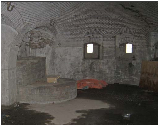
Afbeelding 5. Eén van de caponnières die ingericht zou kunnen worden voor overwinterende vleermuizen. Foto: R.M. Koelman.
