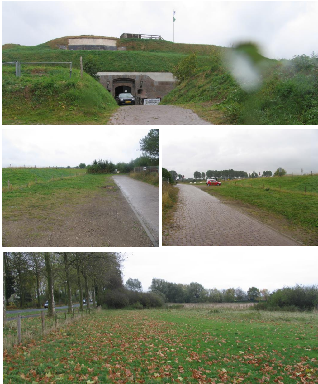
Figuur 2: Huidige situatie fort (boven), parkeerplaats aan de Sterreschans (midden) en locatie van het nieuwe parkeerterrein ten noordwesten van de Sterreschans (onder) (foto's SAB, 2012)
