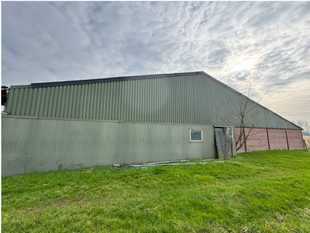
• Afbeelding 11: te slopen stal
