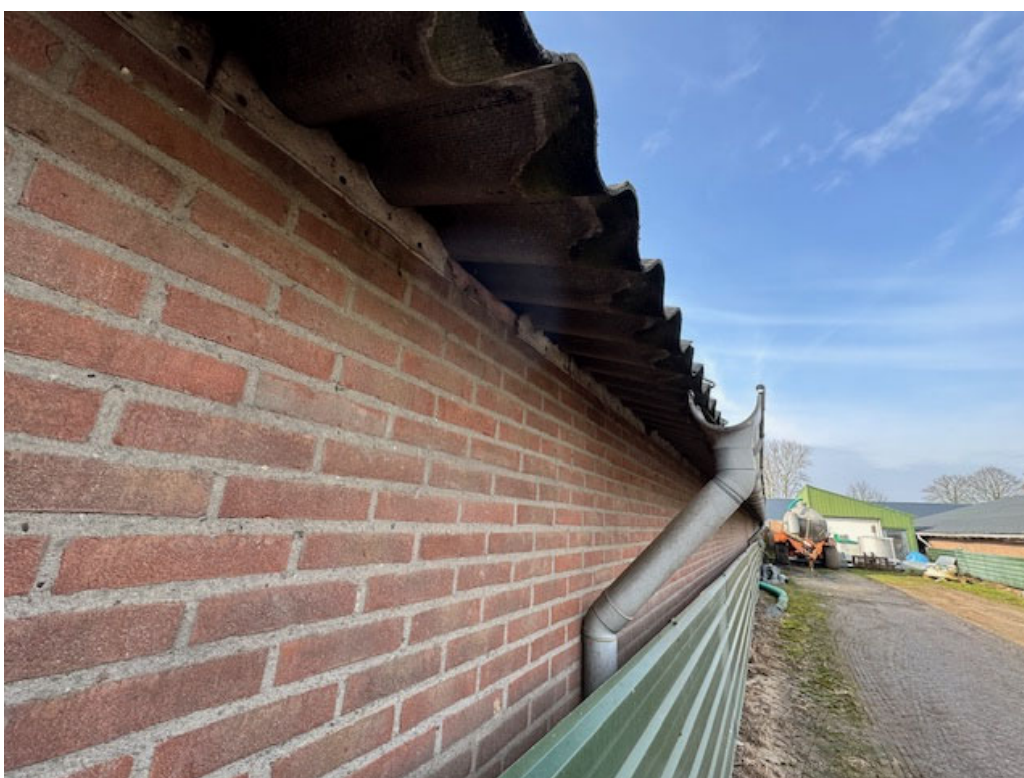
• Afbeelding 30: detail dakaansluiting te slopen stal
