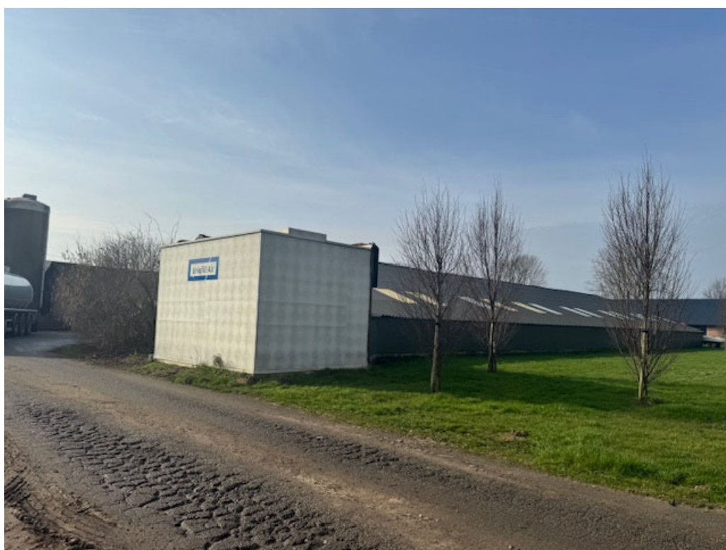
• Afbeelding 34: luchtwasser met daarachter de voorste te slopen stal
