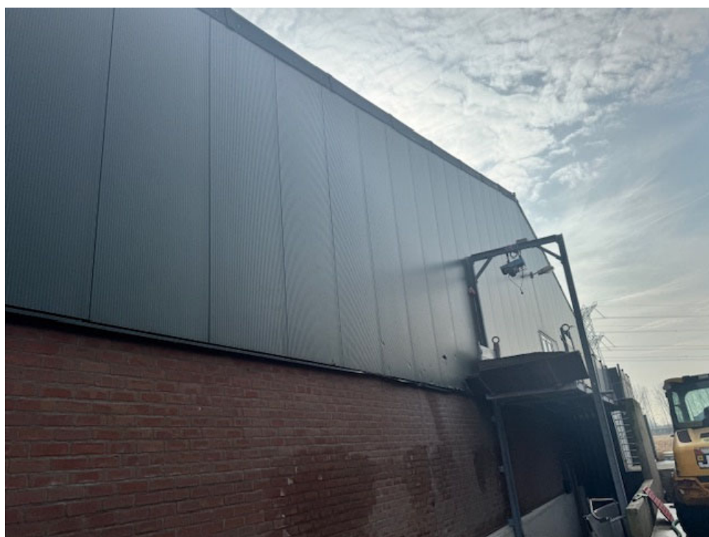
• Afbeelding 26: kopgevel etagestal
