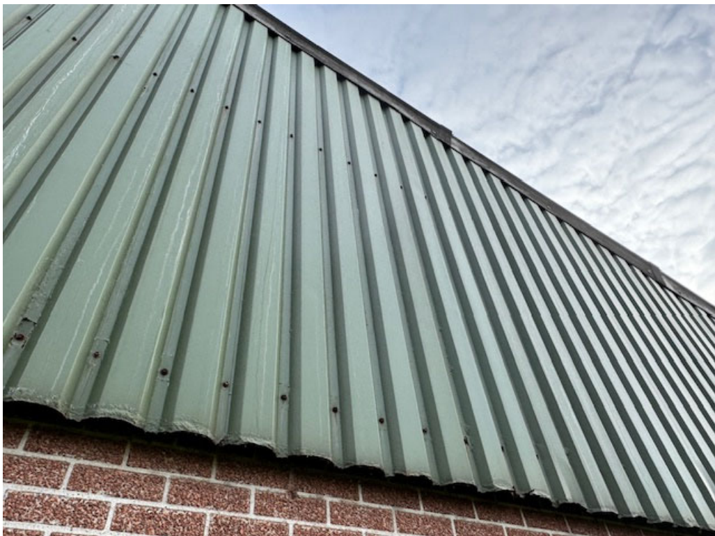
• Afbeelding 12: detail topgevel te slopen stal
