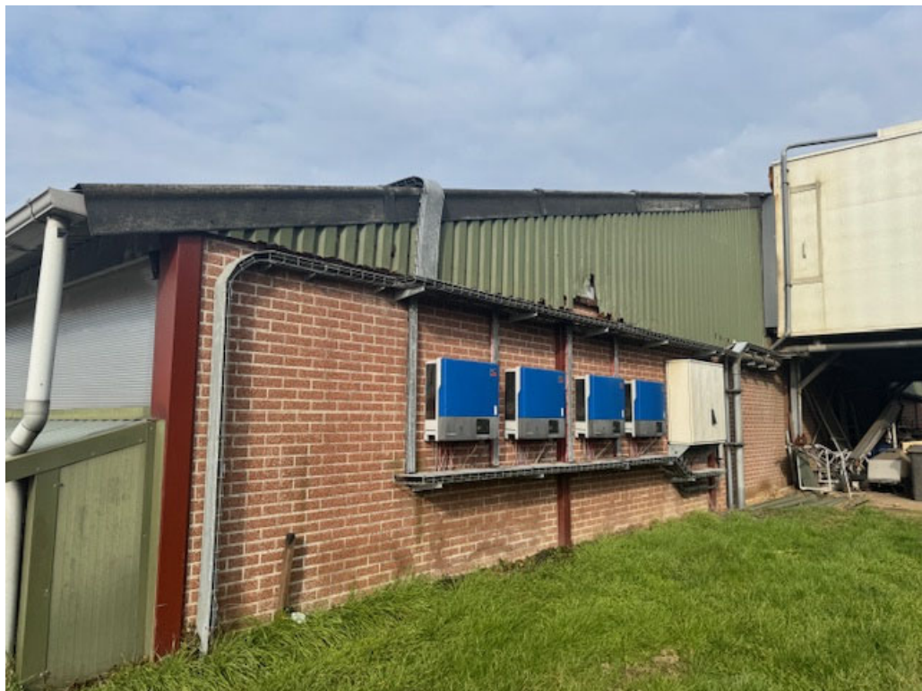
• Afbeelding 18: luchtwater en omvormers zonnepanelen
