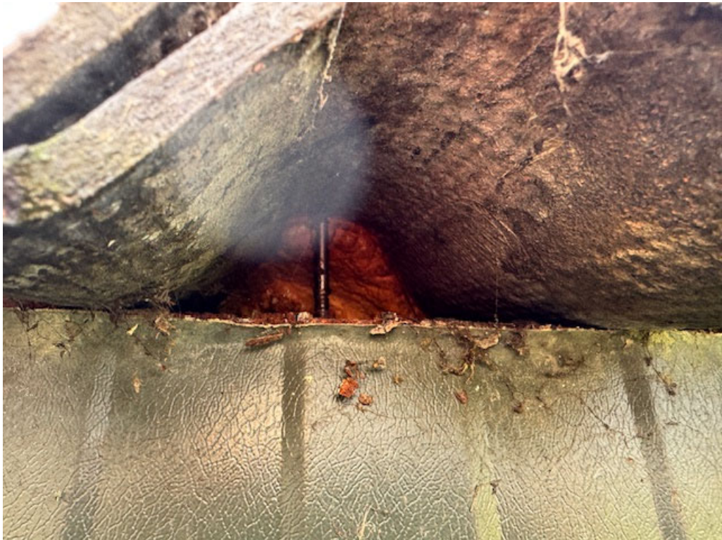
• Afbeelding 37: onderzijde golfplaten dicht gezet met pur
