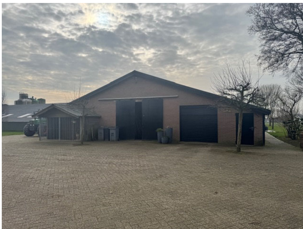
• Afbeelding 6: voorgevel schuur die behouden blijft
