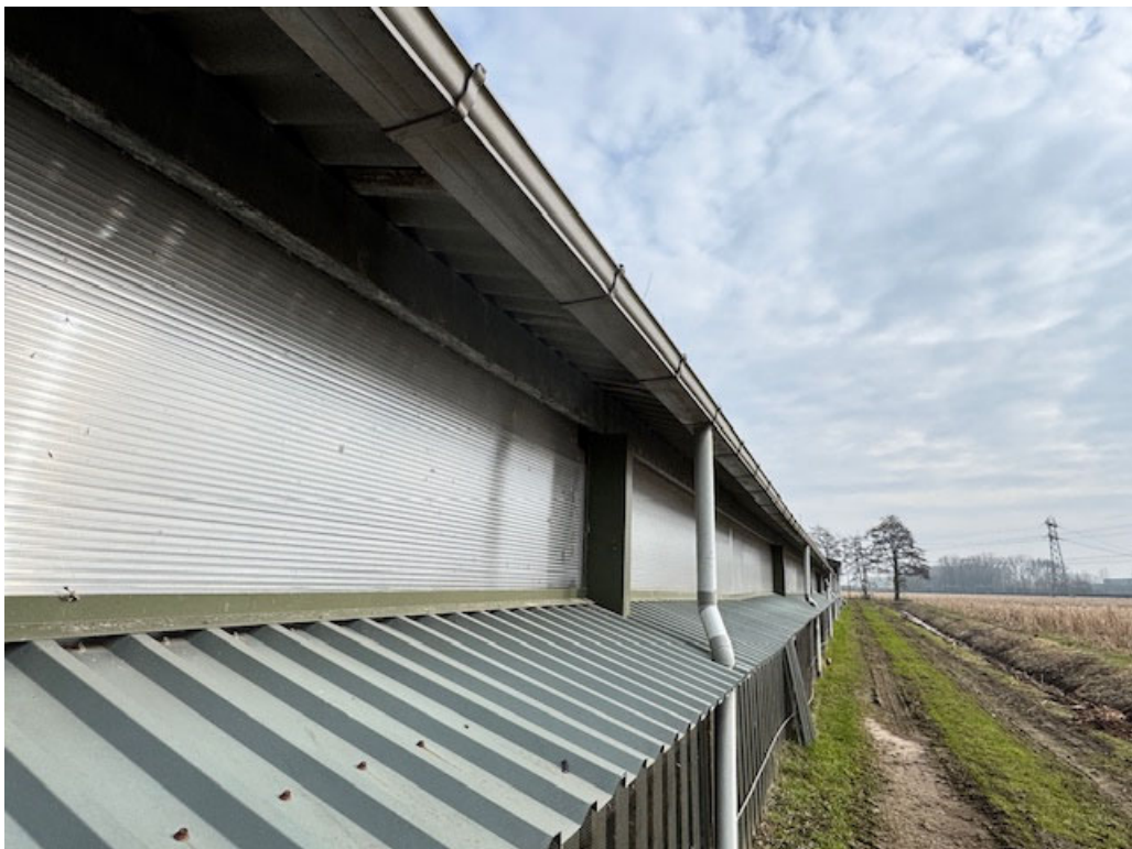
• Afbeelding 16: achtergevel te slopen stal
