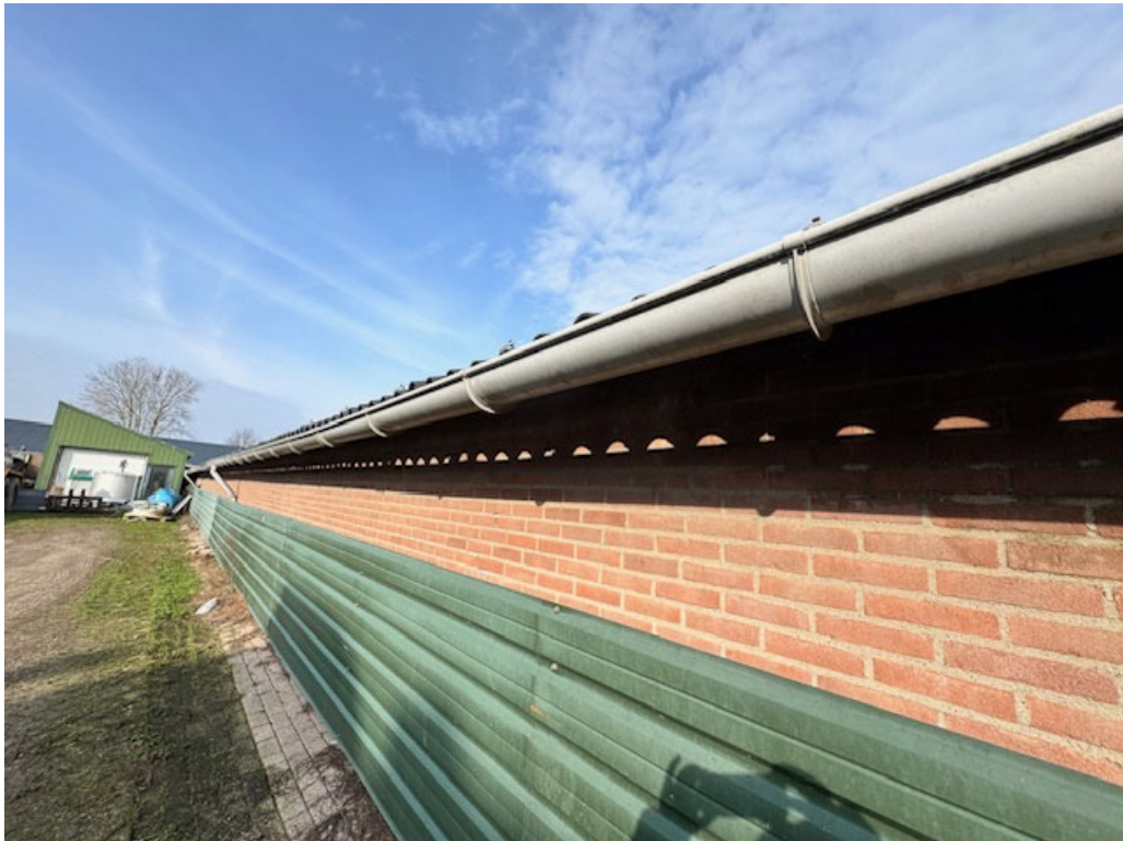
• Afbeelding 31: achtergevel te slopen stal
