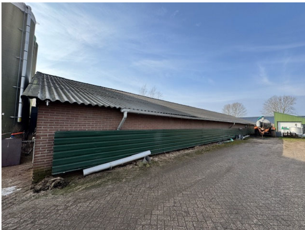
• Afbeelding 29: voorgevel te slopen stal met erfverharding
