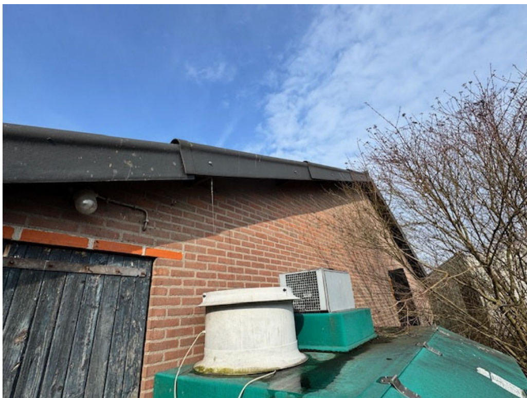
• Afbeelding 33: kopgevel te slopen stal
