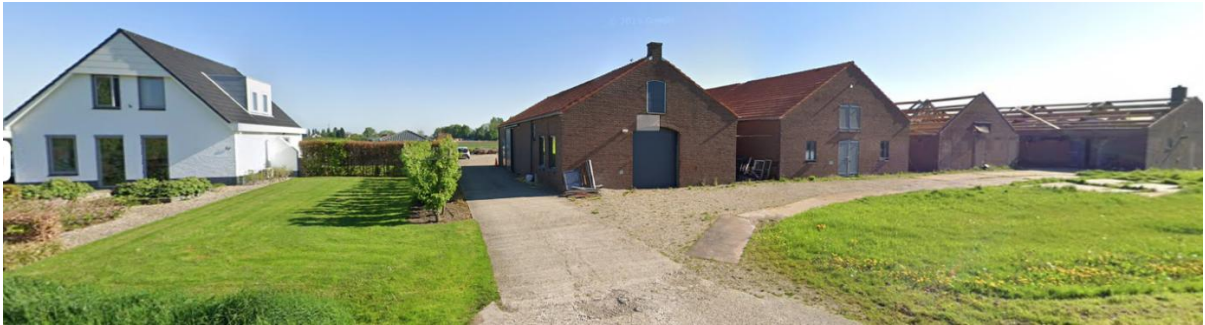
Afbeelding bestaande situatie
