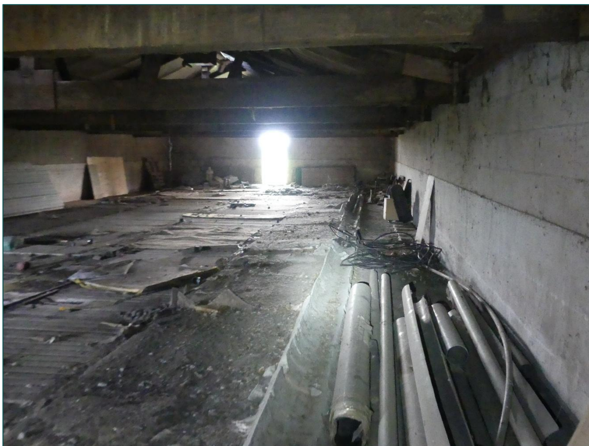
Figuur 3 De loodsen zijn toegankelijk via openingen in het dak en in de muren.
