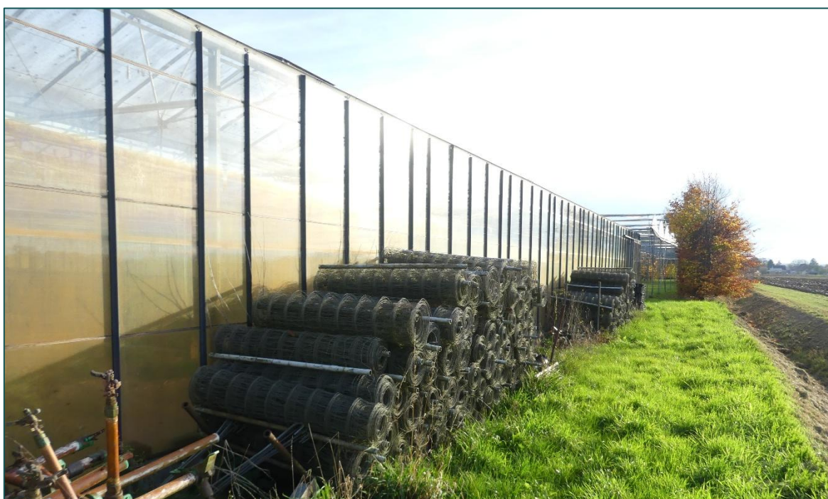
Figuur 4 Achterzijde van het kassencomplex, westelijke kant.
