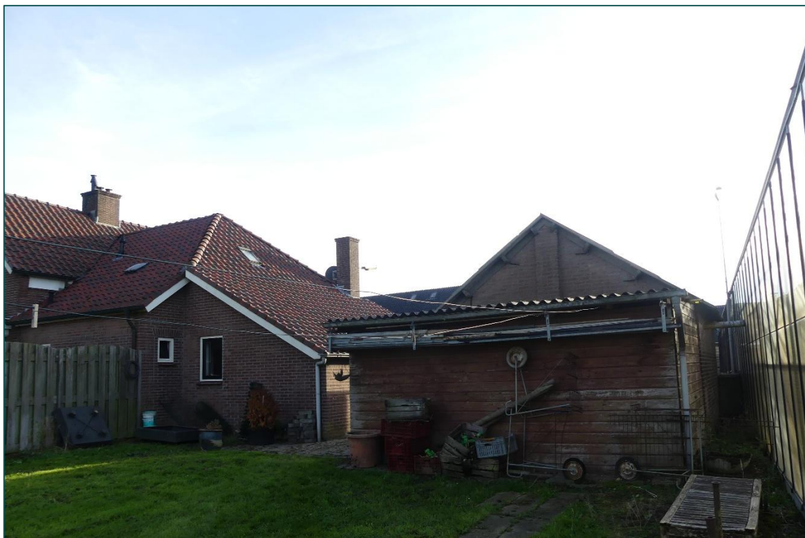
Figuur 2 Achterkant van het huis en de schuur, gezien vanaf de noordelijke kant.
