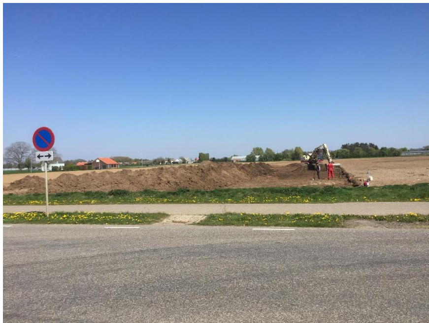
Figuur 7: Laagsgewijs ontgraven perceel F.
