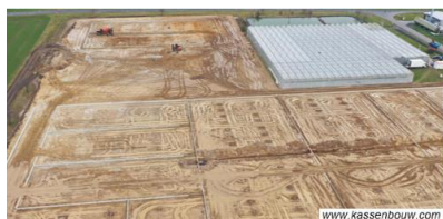
Voorbeeld bouwrijp maken voor kassenbouw
