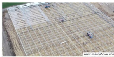
Voorbeeld oprichten staalconstructie
