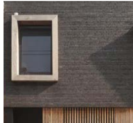
Accentueren van de gevelopening
