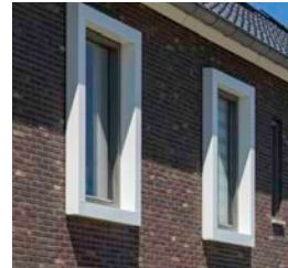
Accentueren van de gevelopening
