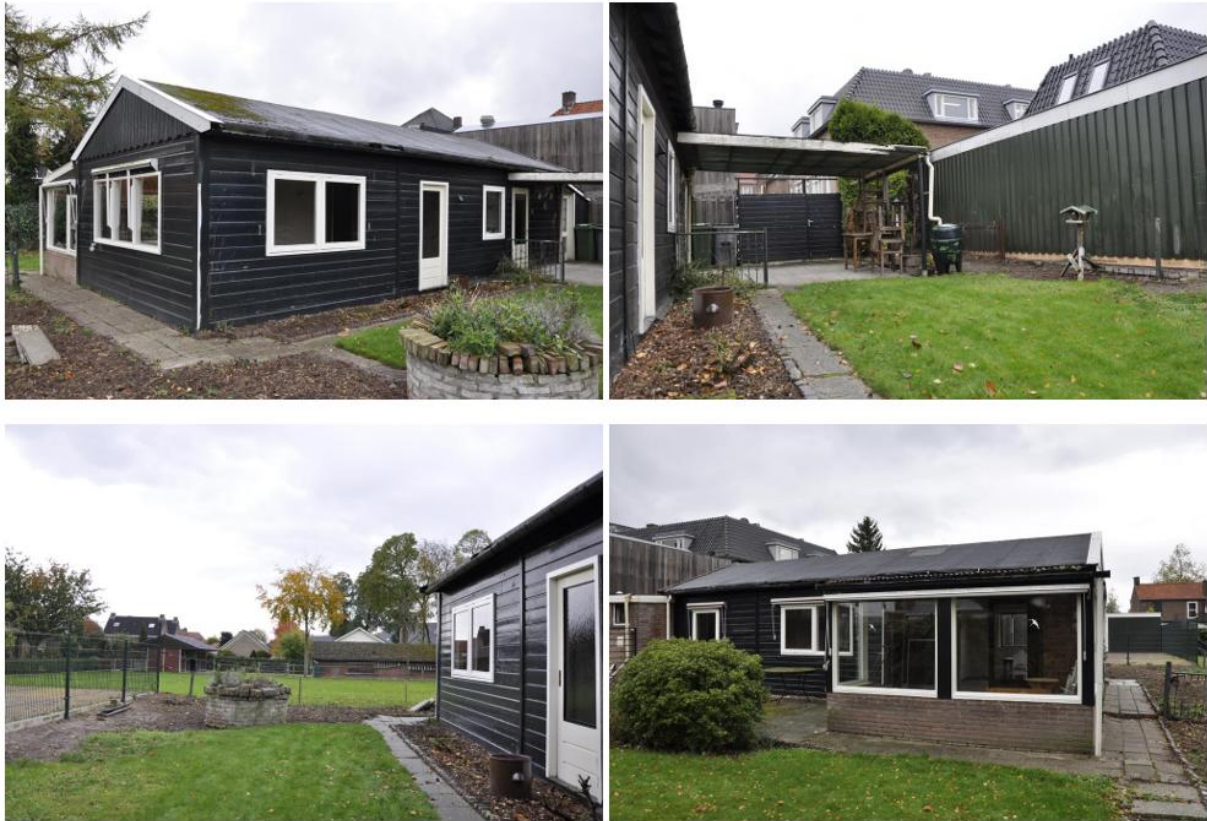
Foto's bestaande situatie
