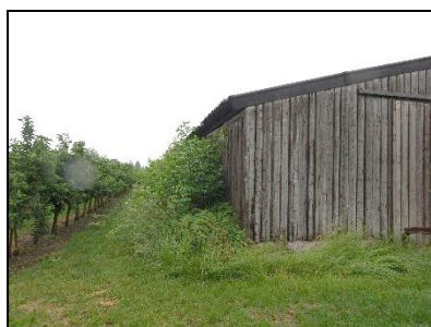
Figuur 15. Braamstruwelen westkant te slopen schuur.
