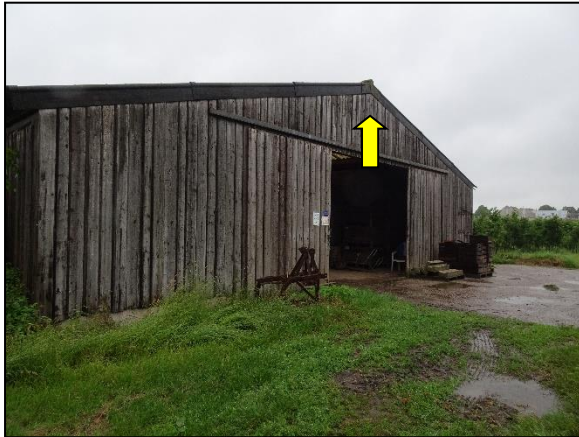
Figuur 13. Ruimte onder het daklood.
