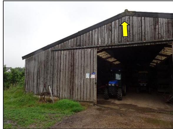
Figuur 14. Ruimte onder het daklood.
