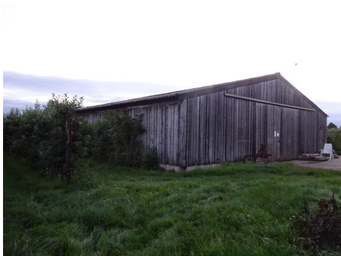
Foto 1 | Golfplaten en vormstukken
