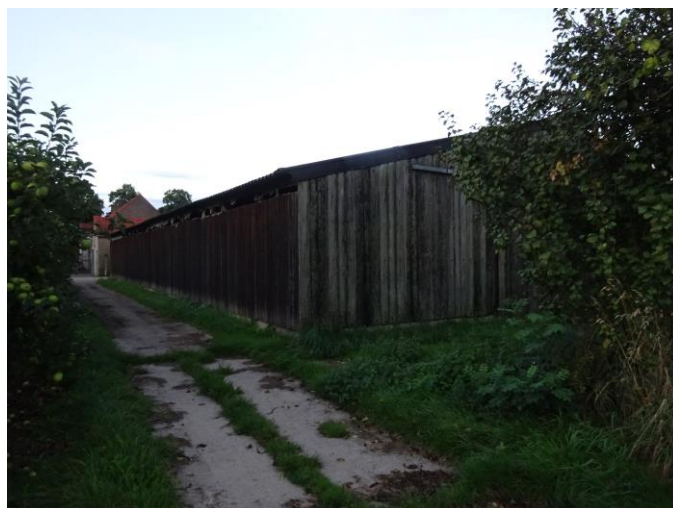
Foto 2 | Golfplaten en vormstukken
