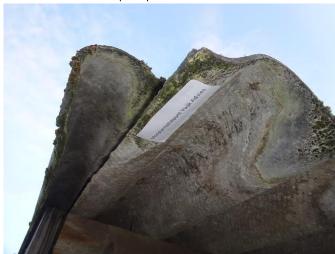
Foto 4 | Golfplaten en vormstukken
