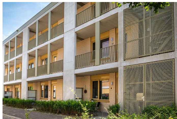
► Galerij geïntegreerd in het ontwerp van het gebouw
