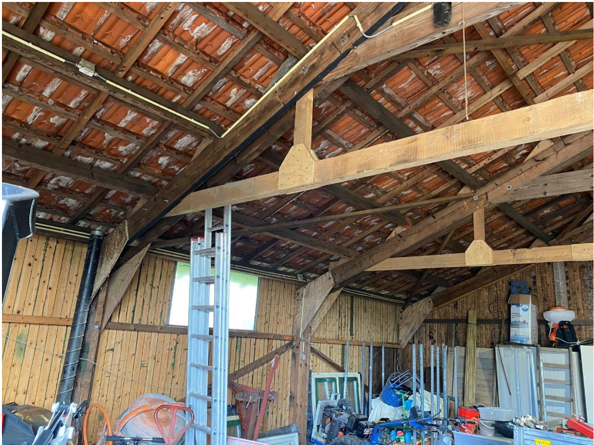
foto van de bestaande schuur binnenzijde
