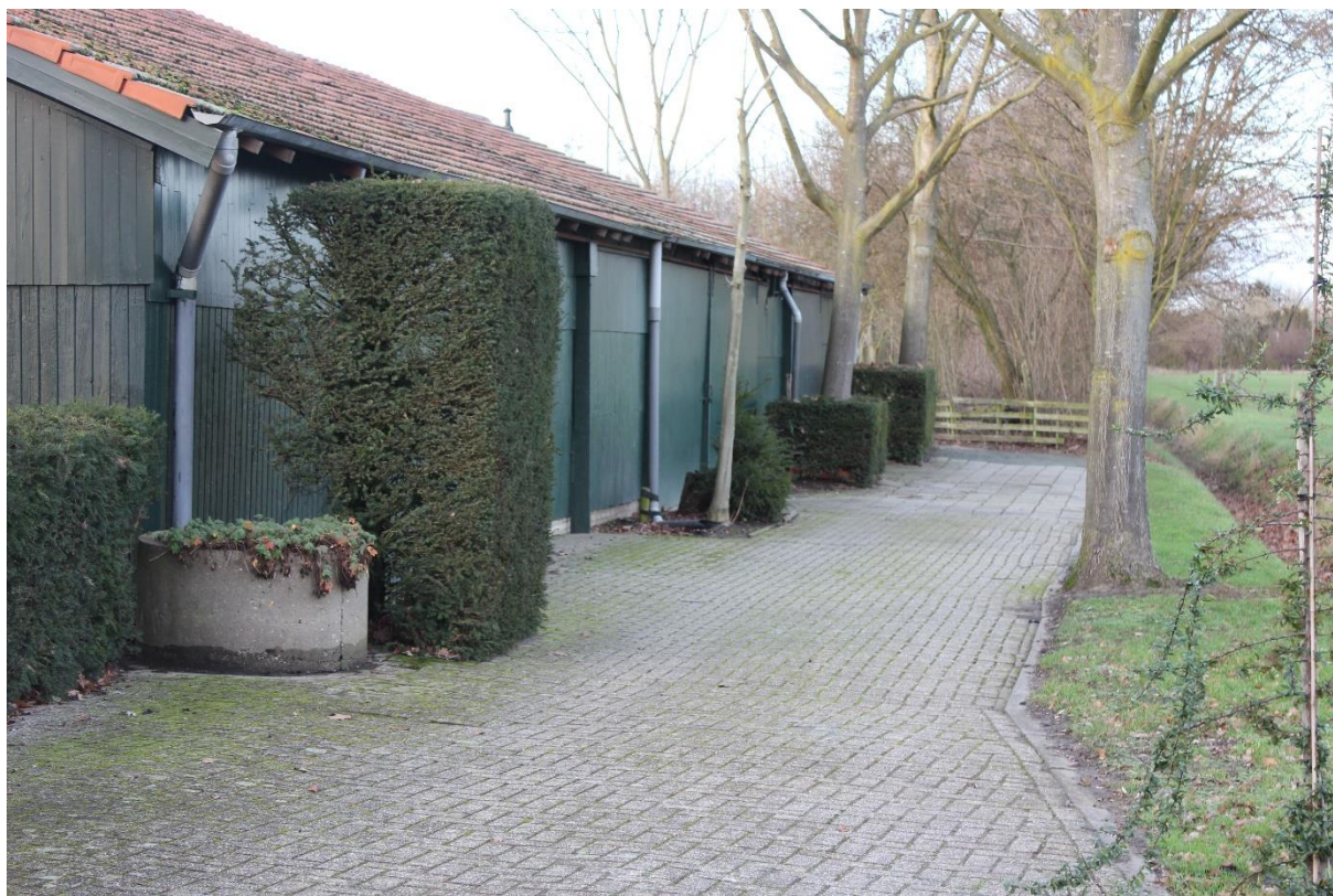
foto van de bestaande situatie, met rechts de A-watergang en zichtbaar de afwatering van het hemelwater op het oppervlak
