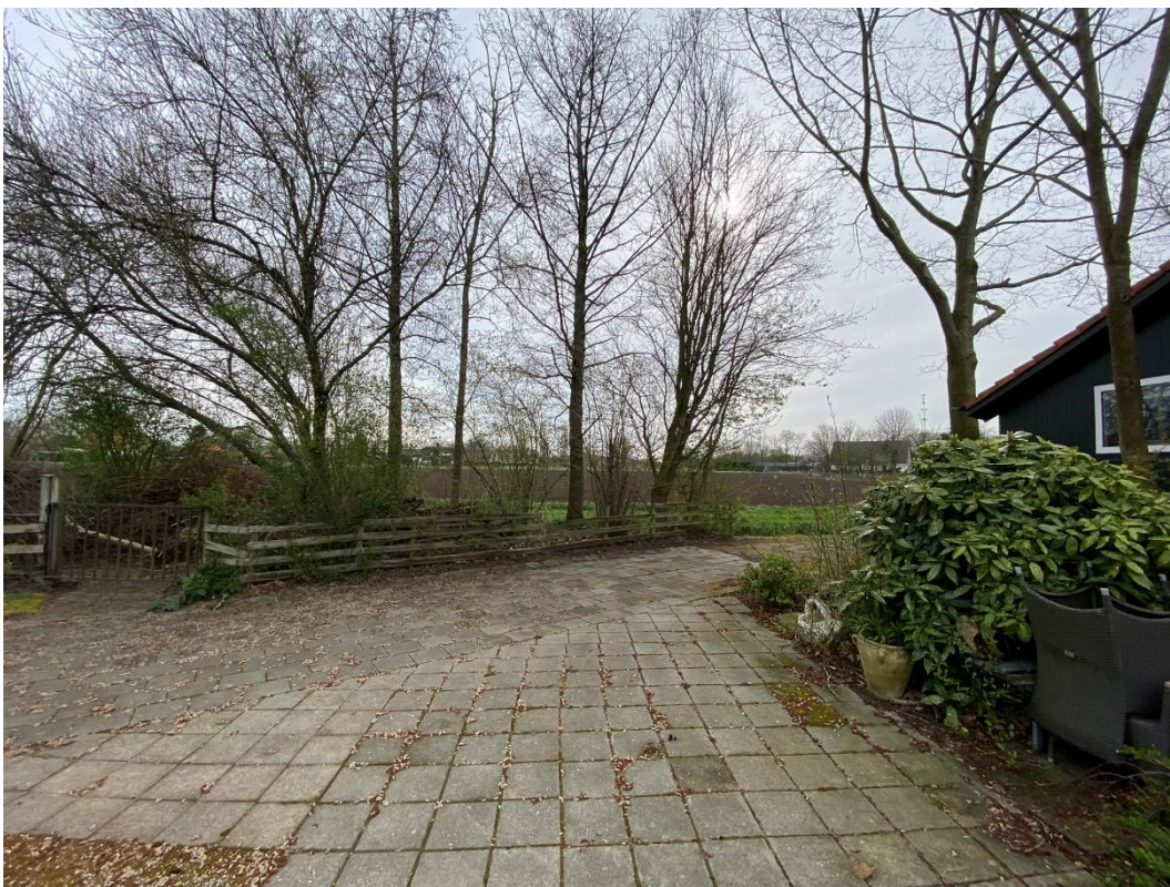
Achterzijde schuur (noordelijk)
