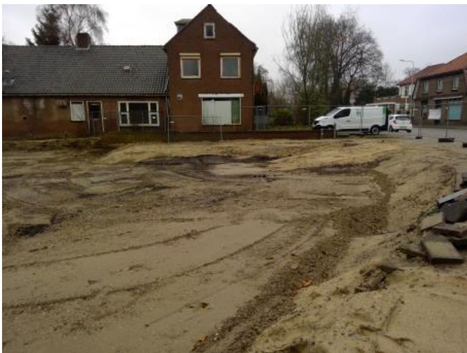
Foto 17: Saneringslocatie na aanvulling en egalisatie zicht vanaf nummer 72 naar nummer 68
