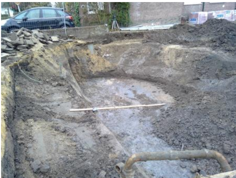
Foto 3: Overzicht van de ontgraving van de zuidelijke verontreiniging
