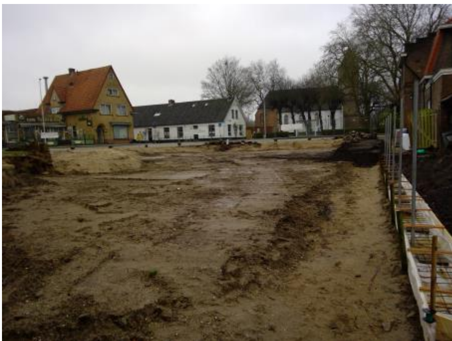
Foto 17: Saneringslocatie na aanvulling en egalisatie zicht vanaf voormalige ligging depot D1
