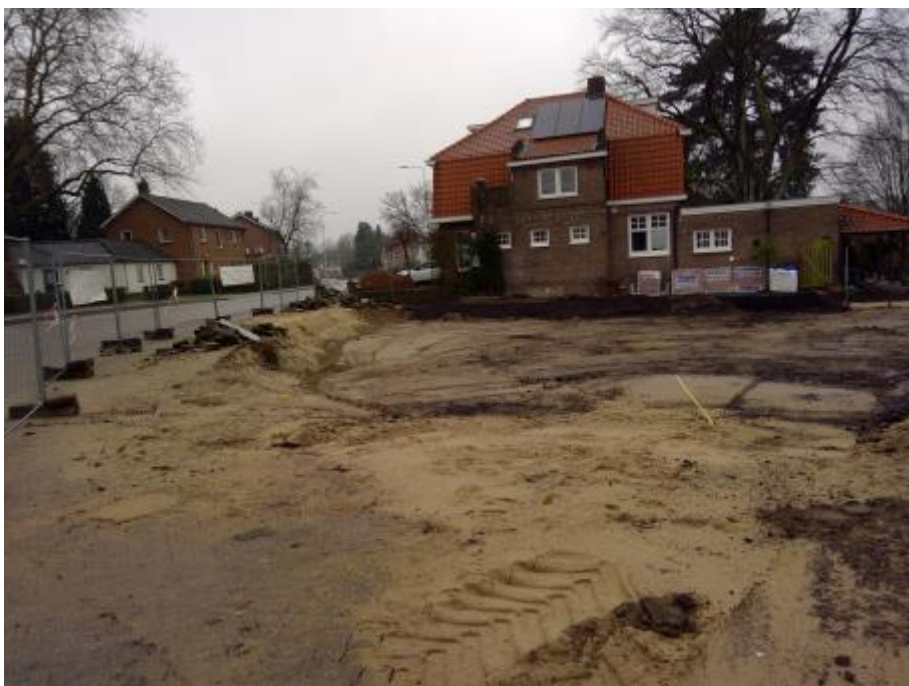
Foto 15: Saneringslocatie na aanvulling en egalisatie, zicht richting nummer 72
