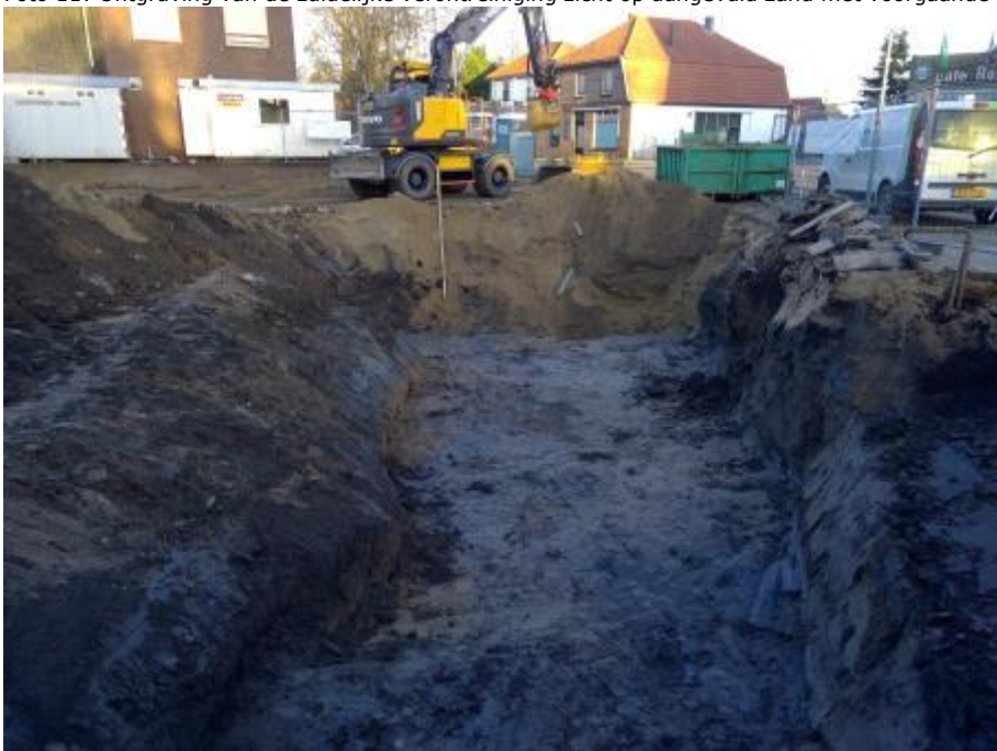
Foto 12: Ontgraving van de zuidelijke verontreiniging zicht op aangevuld zand met voorgaande sanering
