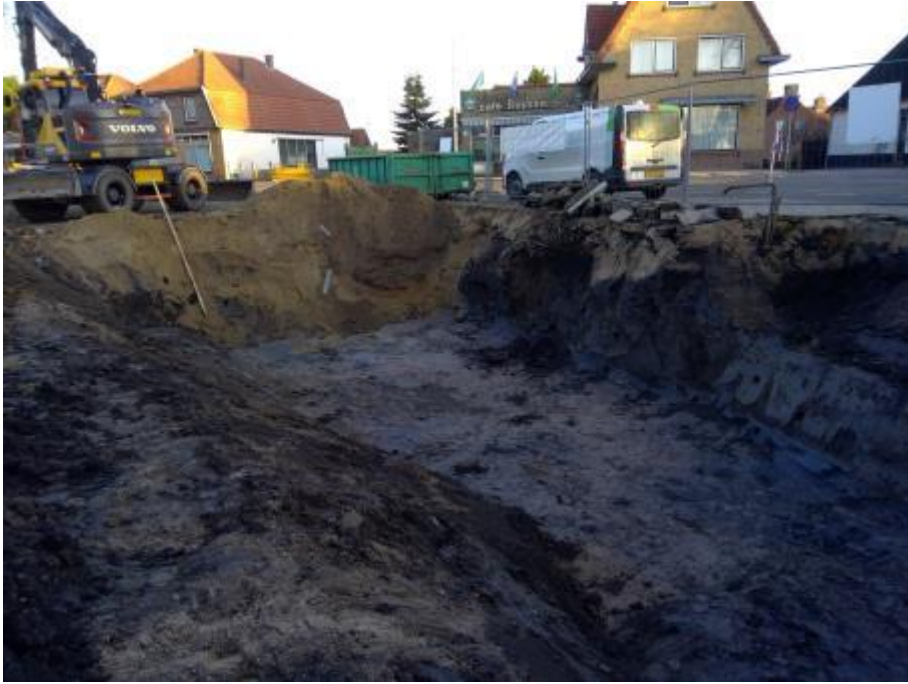
Foto 11: Ontgraving van de zuidelijke verontreiniging zicht op aangevuld zand met voorgaande sanering
