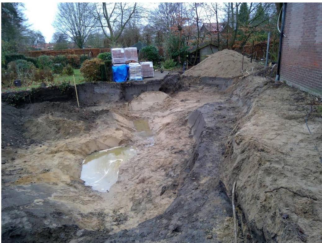
Afbeelding 3: Overzicht ontgraving noordelijke verontreiniging met depot D1. Foto is van zuid naar noord genomen.
