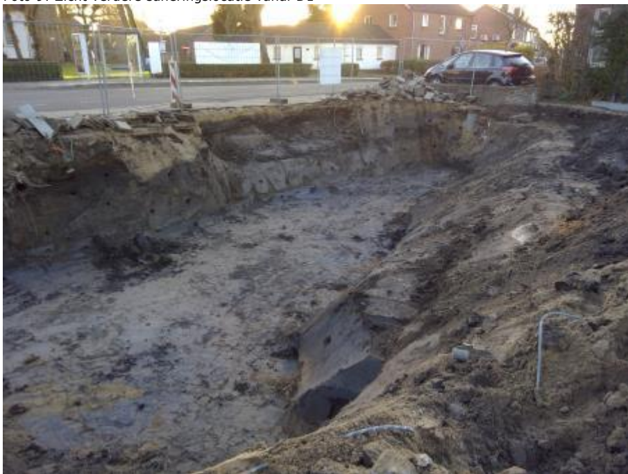
Foto 10: Zicht op ontgraving zuidelijke ontgraving, zich richting gesaneerde benzinetank
