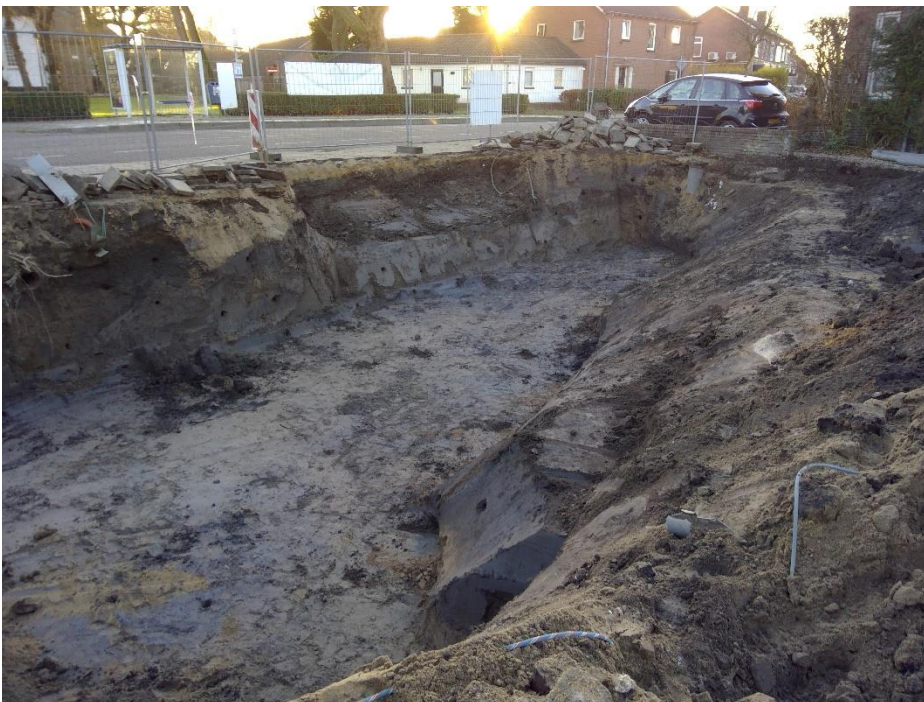
Afbeelding 5: Ontgraving zuidelijke verontreiniging, de wanden van de voormalige tank aan de Dorpsstraat zijn zichtbaar.
