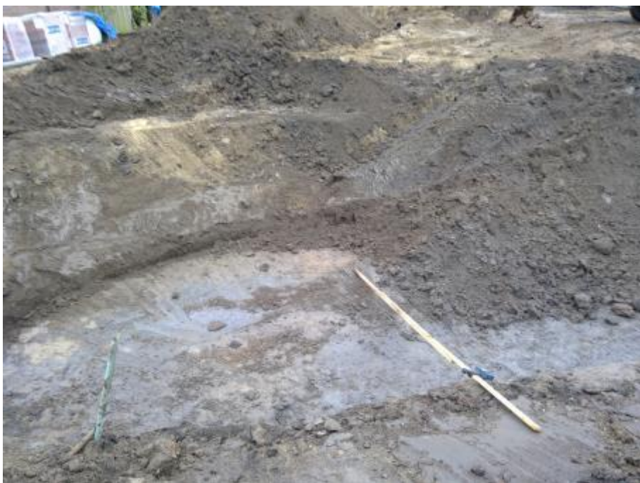
Foto 5: Zicht op B10 van de ontgraving van de zuidelijke verontreiniging
