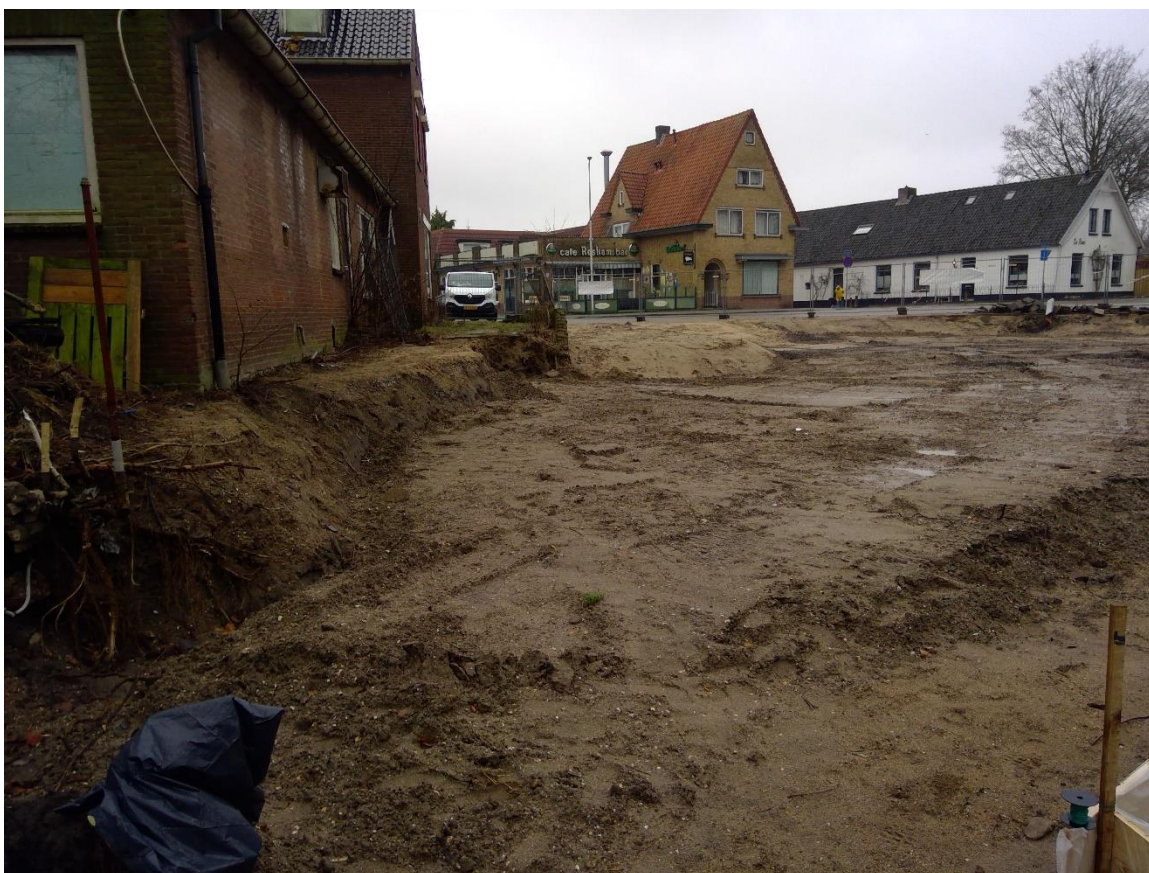
Afbeelding 6: Locatie na aanvulling en egalisatie met de locatie-eigen bovengrond. Foto is genomen van noord naar zuid.
